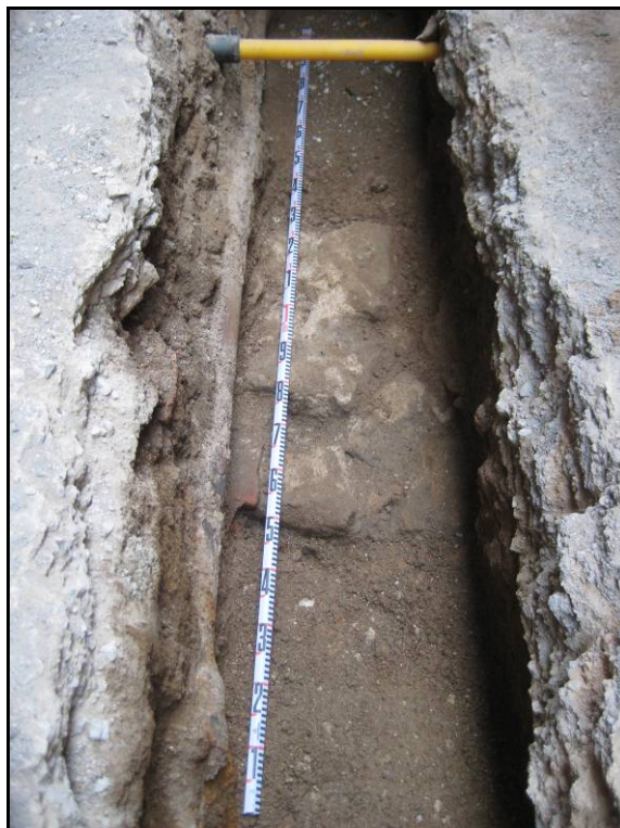
Fotografia 3. Detall del mur U.E:04, localitzat durant els treballs.
