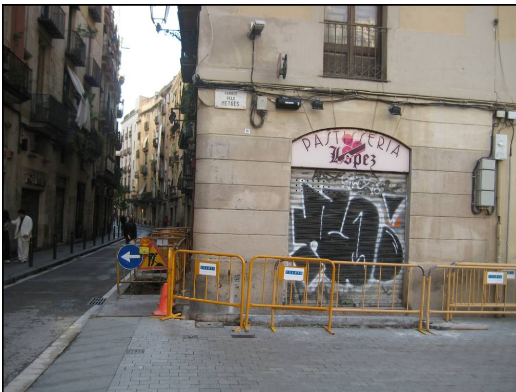
Fotografia 7. Tram obert al carrer dels Metges per poder fer la nova connexió.
